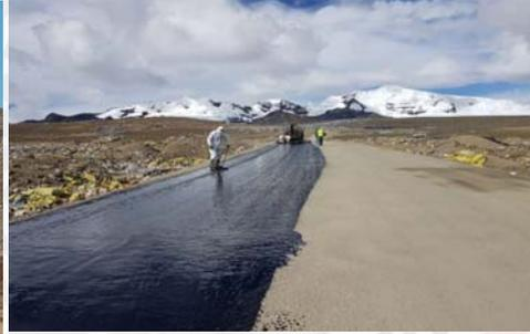
**META:** 08 KM DE SUPERFICIE DE RODADURA A NIVEL DE CARPETA ASFALTICA
